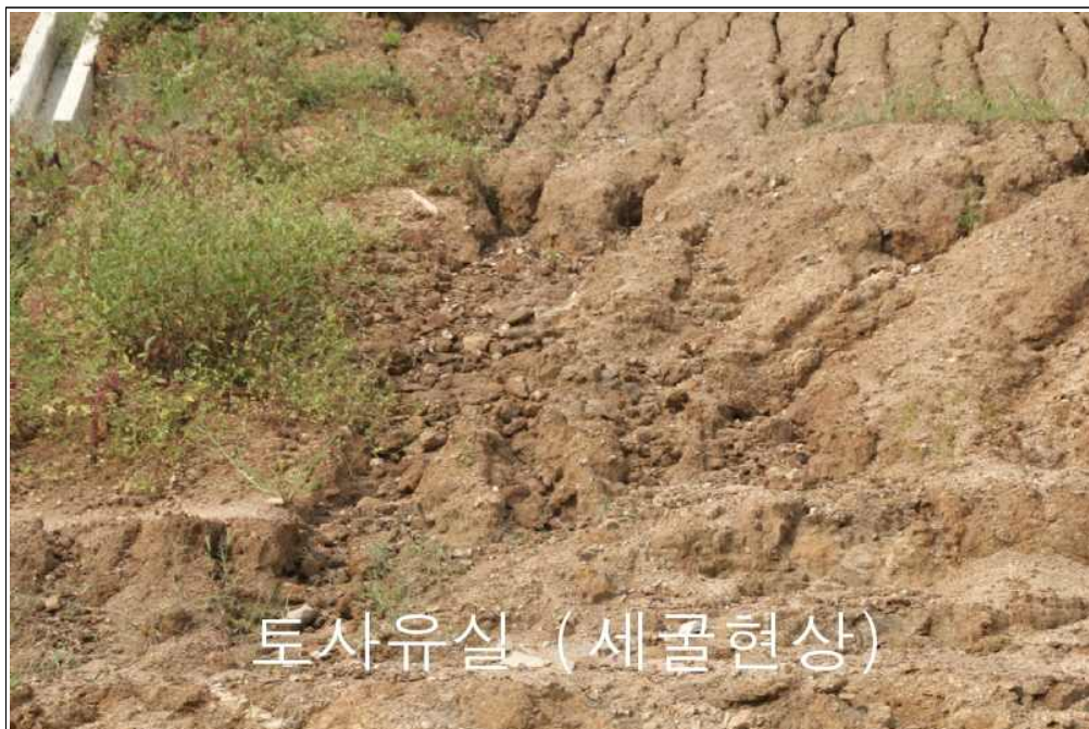
【그림 29】 E 영역 상세사진 (토사유실)
