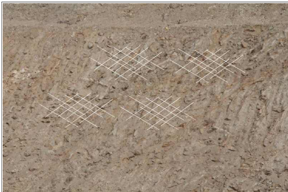
【그림 17】 A 영역 상세사진 (세편화된 암석)
