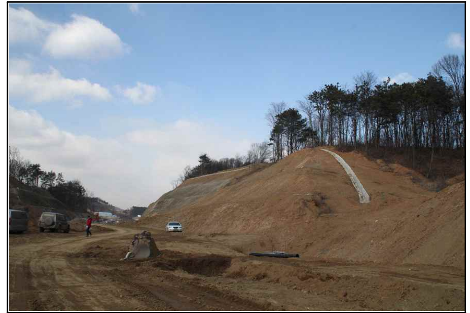
【그림 4】 깎기비탈면 종점부 측면 사진
