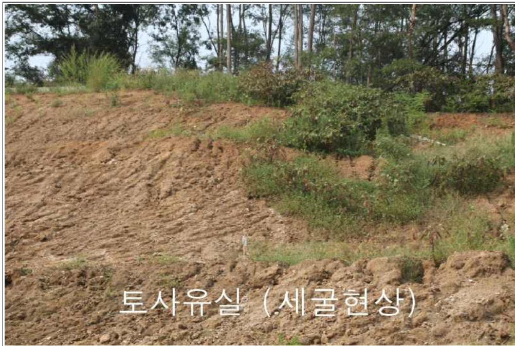
【그림 28】 E 영역 상세사진 (토사유실)
