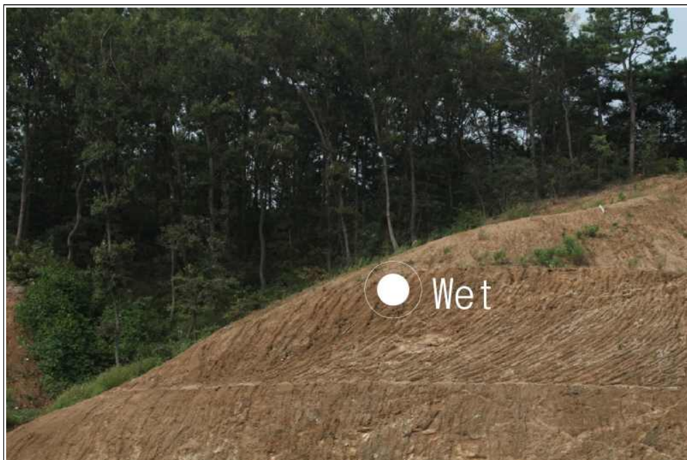
【그림 20】 B 영역 상세사진 (지하수 유출)
